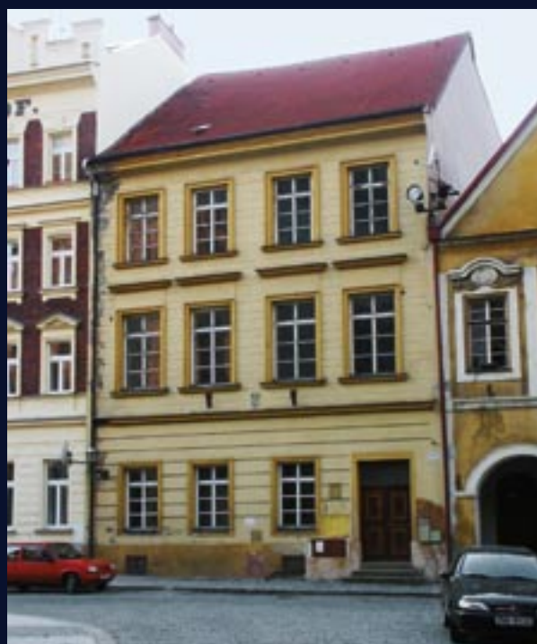
22. Budova budoucího sídla rektorátu UHK
