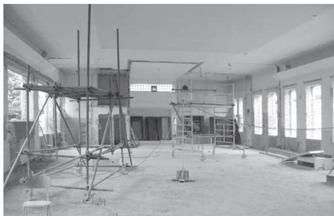
Obr. Průběh rekonstrukce části objektu Váta Nejedlého 573
