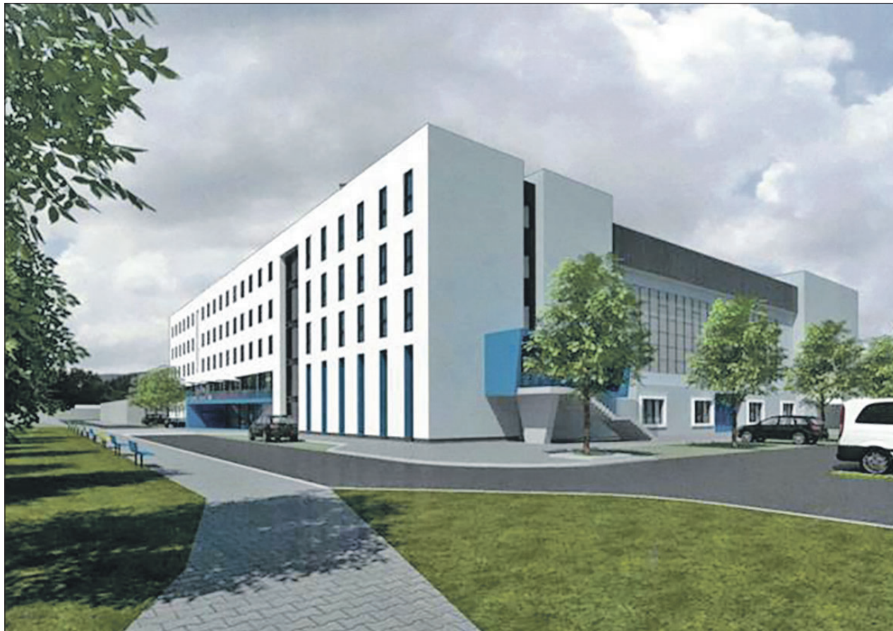
Opravená budova ubytovny se vyznačuje střídavým designem.
