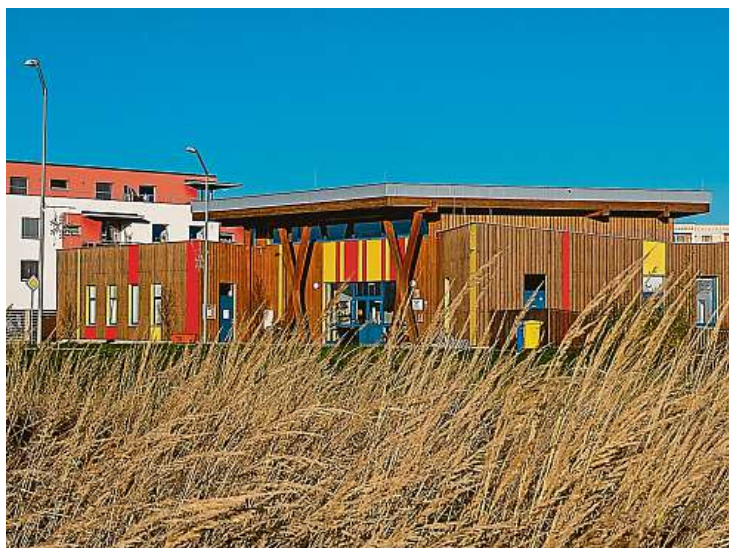
Mateřská škola v Podzámčí přestává stačit.
