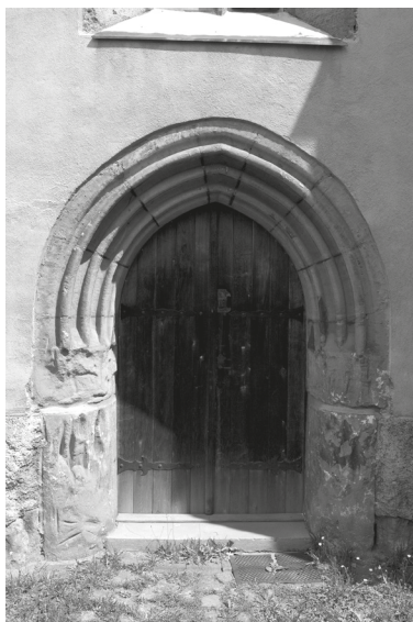
Obr. 12: Skuteč, kostel Božího Těla, jižní portál. Zdroj: Archiv autorky
