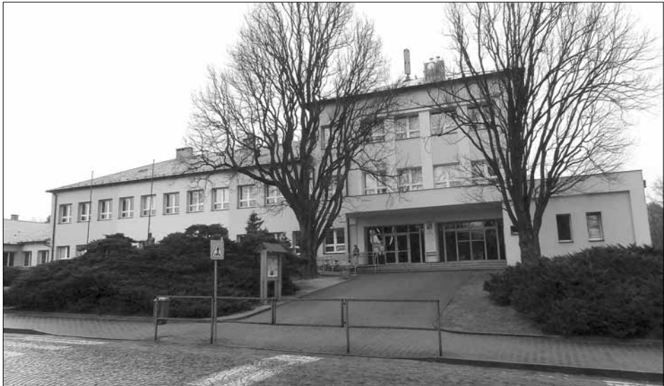
Obr. 12: Současný stav školy v Borohrádku po rekonstrukci z roku 2010. Zdroj: Fotoarchiv autora.
