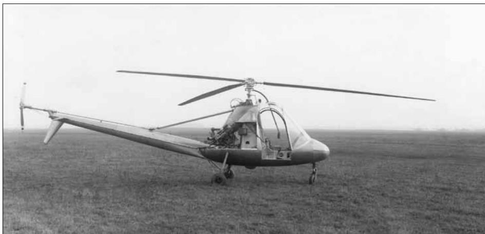
Obr. 2. První prototyp vrtulníku HC-2 s původní (rovnou) kabinou. Zdroj: Soukromý archiv Ing. Ivo Pujmana.
