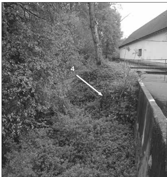
Obr. 10. Základový pilíř jako pozůstatek pilového mlýna – 4 (autor)
