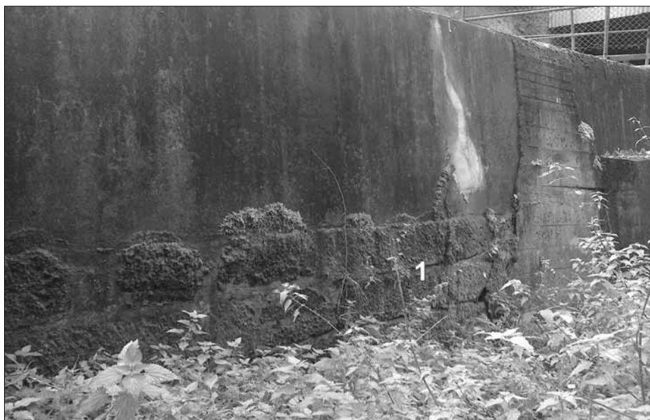
Obr. 9. Pod dřevěnými vantroky tvořily základovou plochu opracované kvádrové pískovcové bloky (1) (autor)
