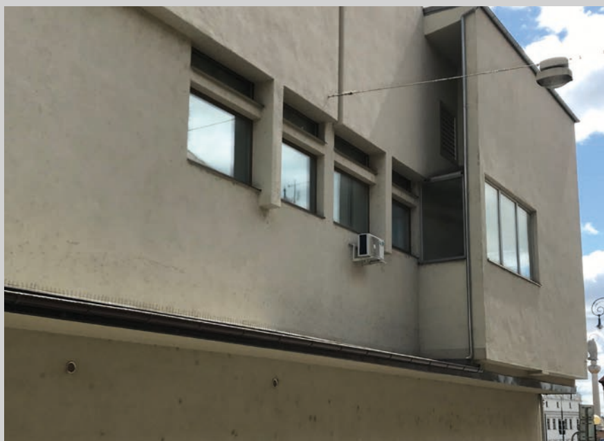
Obr. 3: Znojmo, Obchodní dům Dyje, část bočního průčelí do Zelenářské ulice. Foto Pavel Panoch, 2024.
