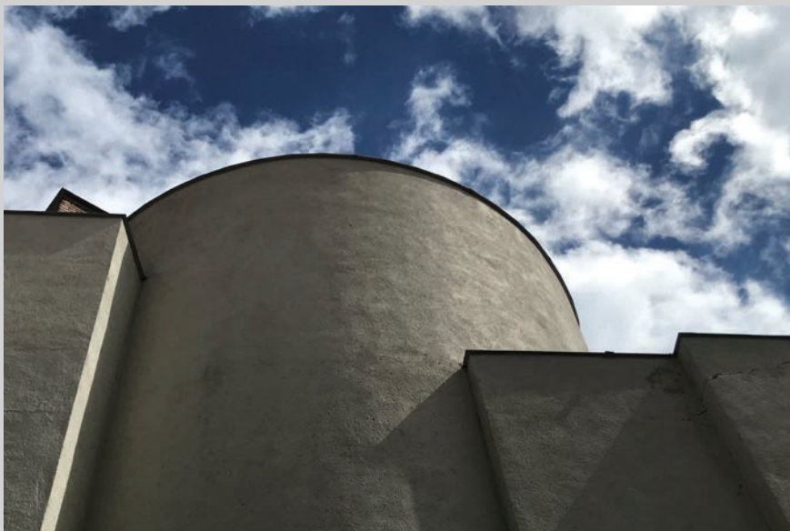
Obr. 4: Znojmo, Obchodní dům Dyje, detail kompozice hmot na bočním průčelí do Zelenářské ulice. Segmentovým prvkem se před líc fasády propisuje válcový tubus schodiště. Foto Pavel Panoch, 2024.
