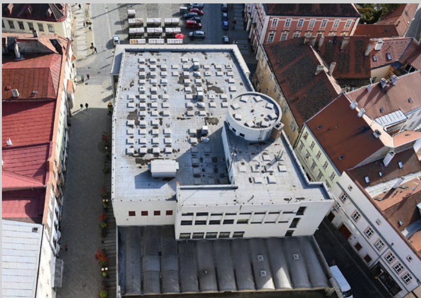
Obr. 5: Pohled z vyhlídkového ochozu znojemské radniční věže na členitou střešní krajinu OD Dyje. Ze střešní nástavby vyrůstá válec schodiště; plochu ploché střechy pokrývá až ornamentálně pravidelný rastr technických otvorů. Foto František R. Václavík, 2022.
